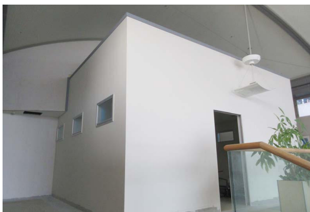
外来化学療法室外観状況
